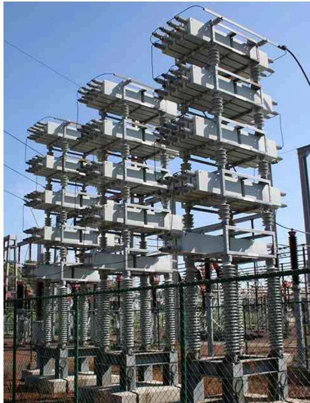
Rysunek 15.14 Kondensatory mocy (ang. power capacitors) używane są do wyrównania impedancji dla wypadkowej indukcyjności linii przesyłowych.
