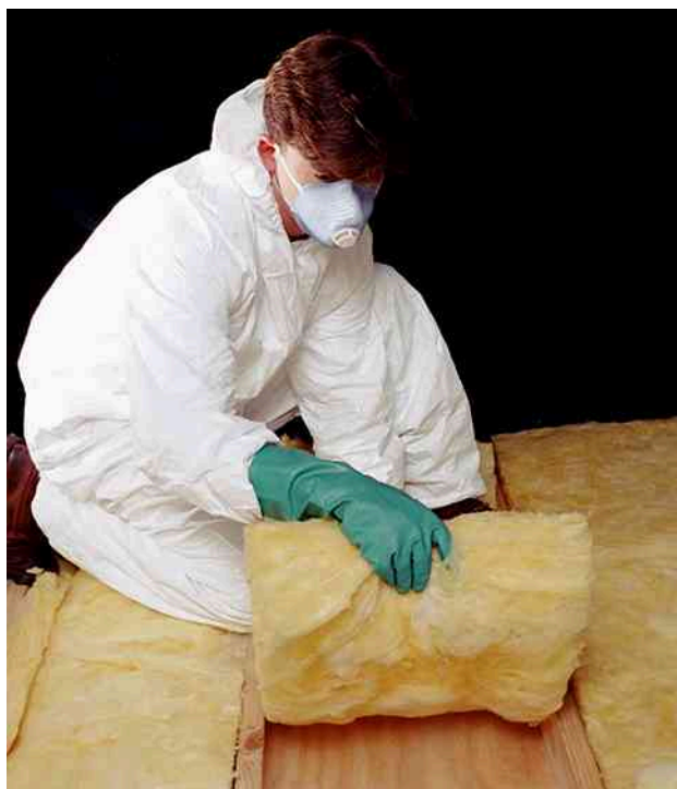
Rysunek 1.23 Płaty z włókna szklanego są używane do budowania izolacji ścian i sufitów, aby zmniejszyć przepływ ciepła pomiędzy budynkiem a środowiskiem zewnętrznym. Źródło: Tracey Nicholls
