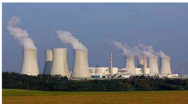
Rysunek 4.5 Ciepło wypompowane z elektrowni atomowych przechodzi do chłodzi komi- nowych, skąd jest uwalniane do atmosfery.
